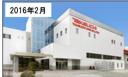
本社・第3工場 竣工 (約30億円)
