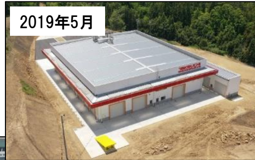
びんぐし試験棟 建設 (約9億円)
