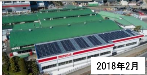
本社・第1工場 増設 (約3億円)
