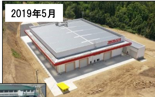
びんぐし試験棟 建設 (約9億円)
