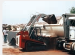
大量の土砂を積み込み
