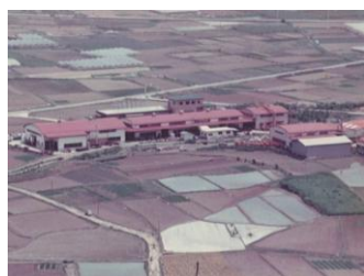
1979年、本社工場内に第二組立工場を新築増設
