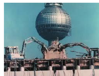
ベルリンの壁の崩壊の際に、使われたのもTAKEUCHIの建機
